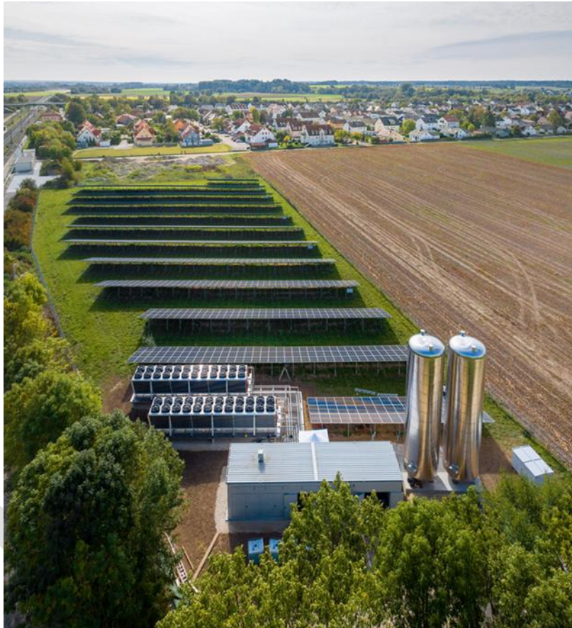
Abbildung 34: Heizzentrale in Mertingen mit 2 Wärmespeichern je 84 m 3
